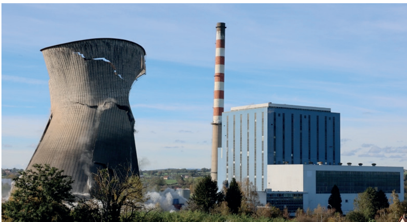
Démolition de la tour aéroréfrigérante et de la cheminée Lucy
