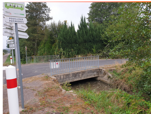
Curage du Taron sur 2m de part et d'autre du pont, à hauteur du Jardinier de Pouilloux
